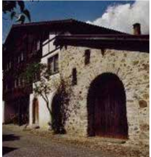
Susthaus Silenen. www.maderanertal.ch
